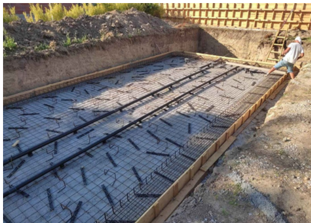
Slika 2. Postavljanje cevnog razvoda i slivnika
